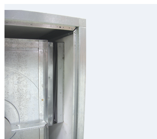
Uszczelnienie po stronie wylotu.
